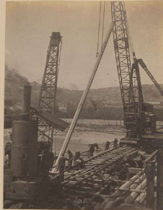
Levantando un pilote para clavarlo.
