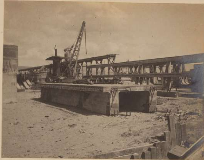
Sección del tablero de concreto armado, terminada.
