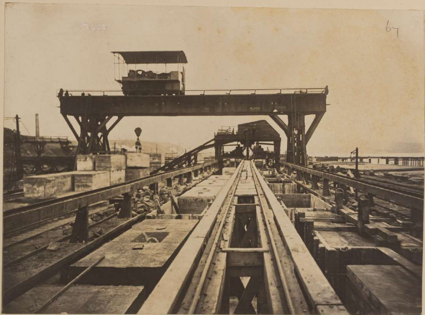
67 Cancha para la fabricación de bloques de concreto en Las Salinas, mostrando la Grúa "Goliath" de 60 toneladas.
