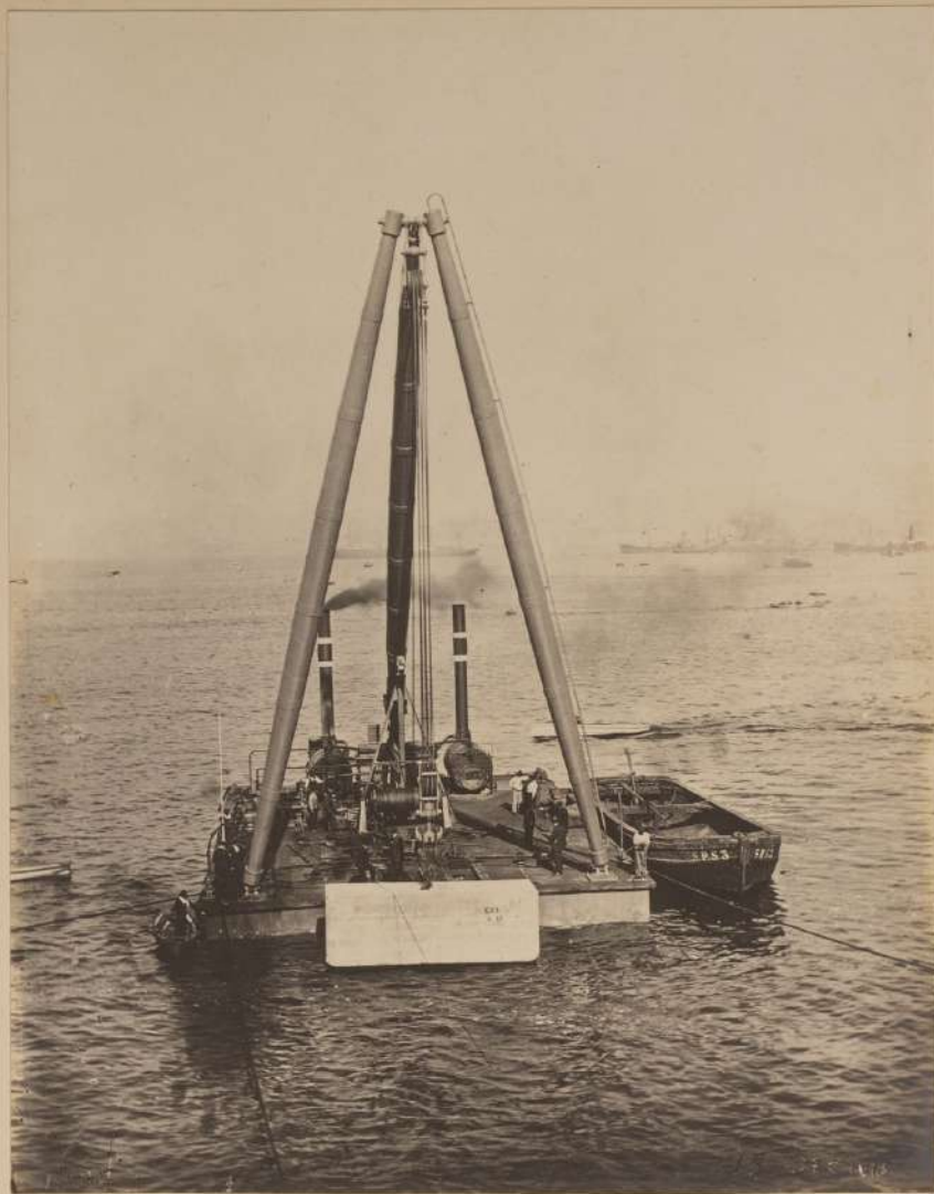
La Grúa Flotante colocando el primer bloque de concreto de 60 toneladas.
