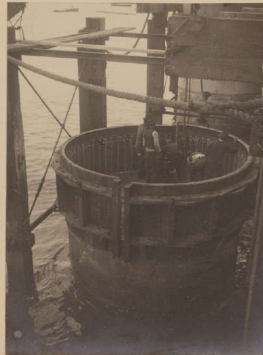
Ajustando moldes para la última sección del cilindro.
