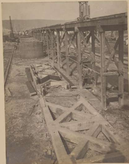
Vigas de defensa, en construcción.
