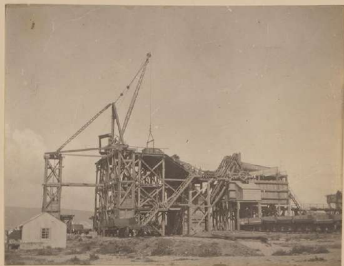
Instalación de Chancadoras de piedra en Las Salinas.
