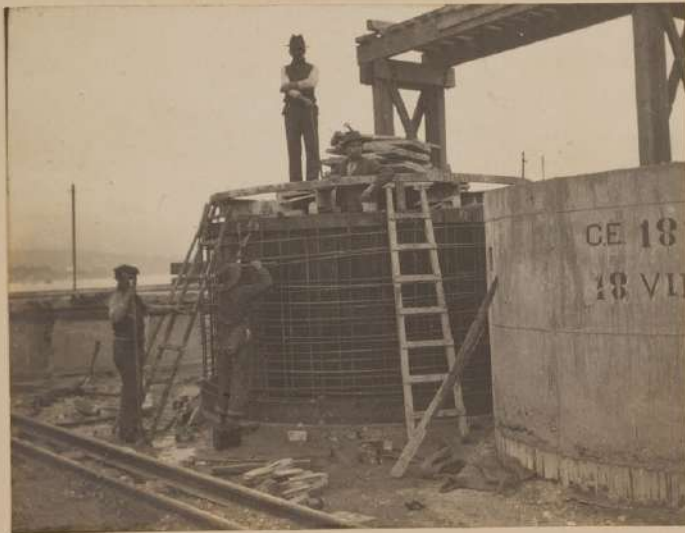
Esqueleto de un cilindro de concreto armado.
