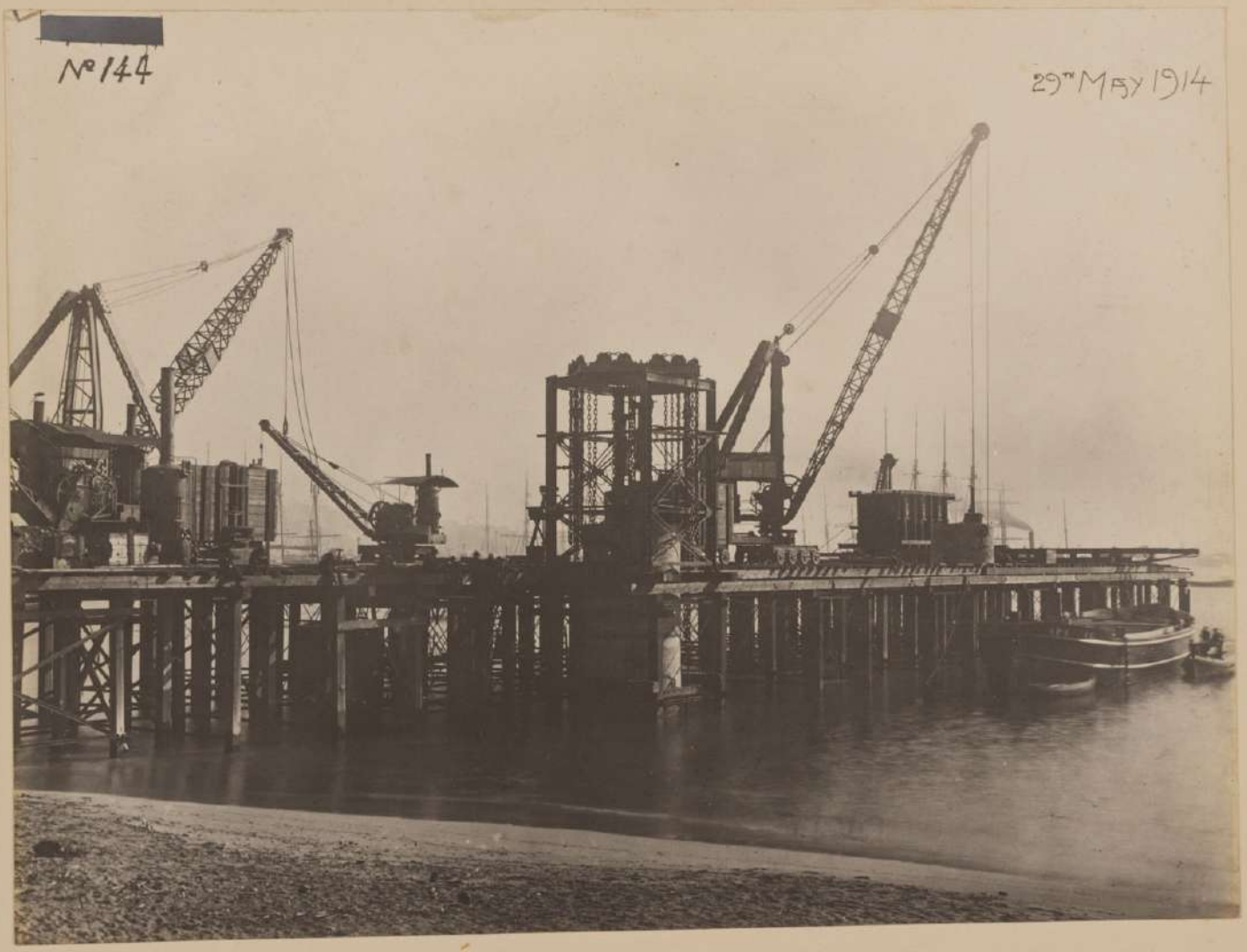
El Muelle para Carbon en construcción.
