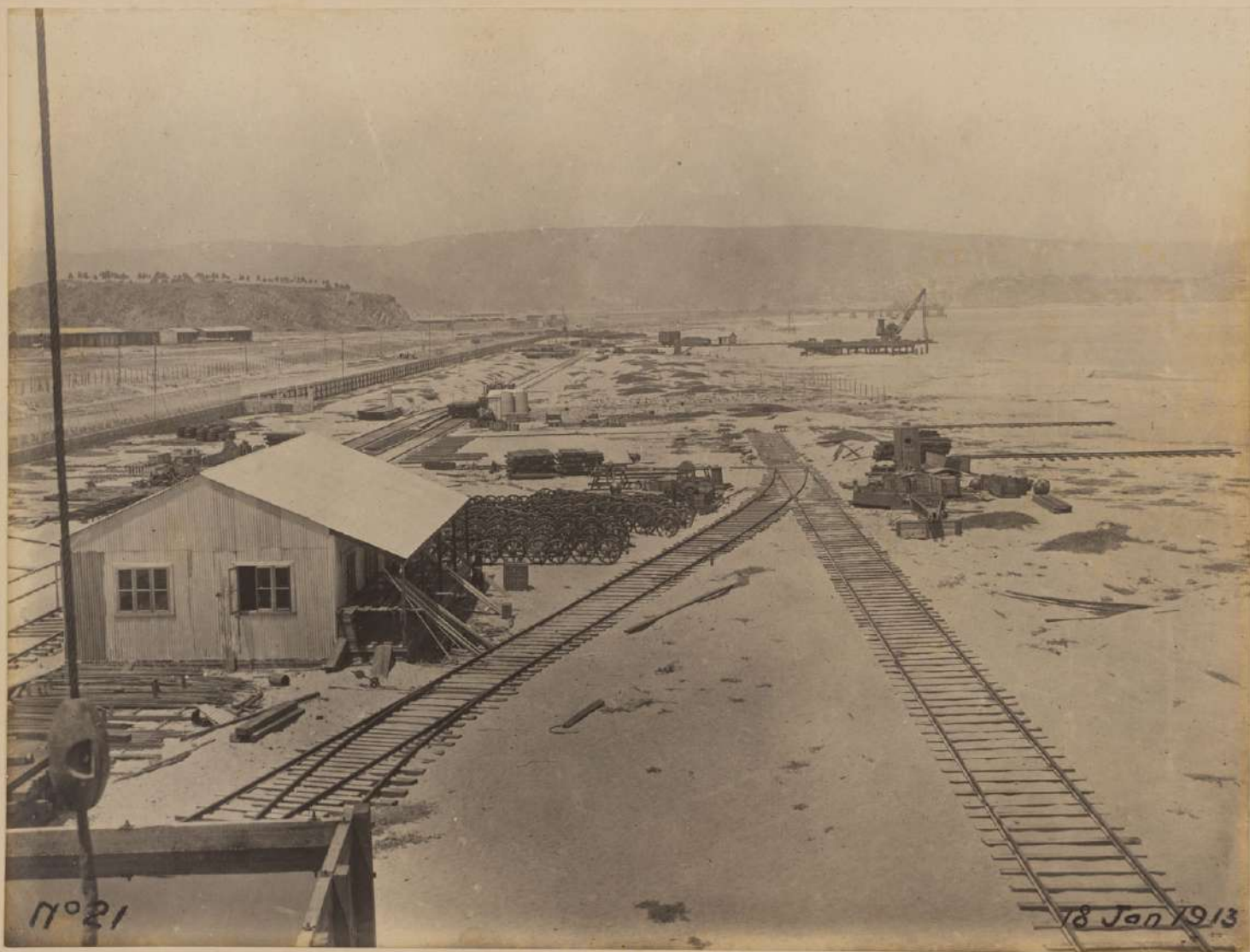
Principiando los trabajos en Las Salinas.
