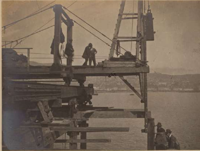
Martinete para clavar pilotes del andamio provisional.
