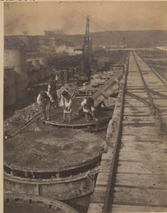
Fabricación de cilindros de concreto armado.
