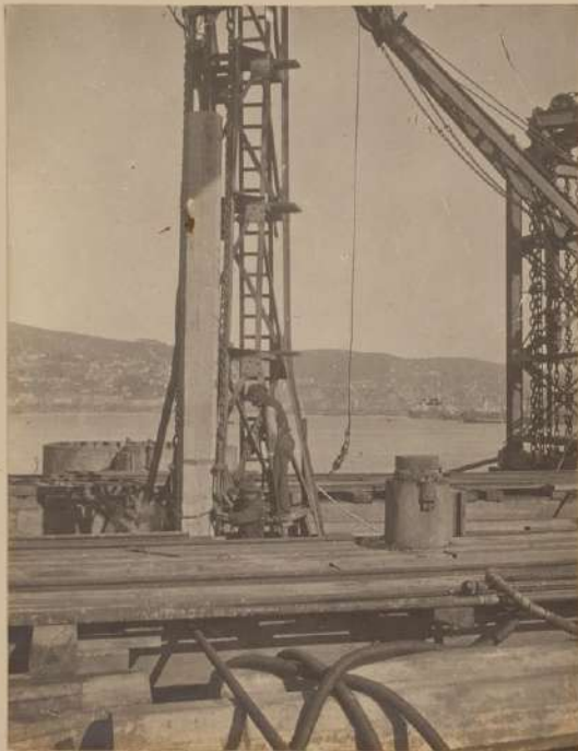
Clavando pilotes adentro del cilindro.
