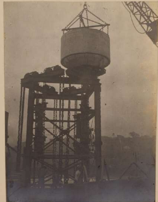
Sección de cilindro de concreto armado en el acto de entrar á la instalación hidráulica para su hundimiento.
