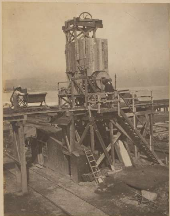
Instalación de Betoneras en la cancha de fabricación de concreto en Las Salinas.
