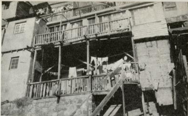
Fig. 9 Casa del Cerro Cordillera. En esta casa los balcones han ido adquiriendo unos múltiples, tales como lavadero, patio, gallinero, terraza, mirador, etc.
