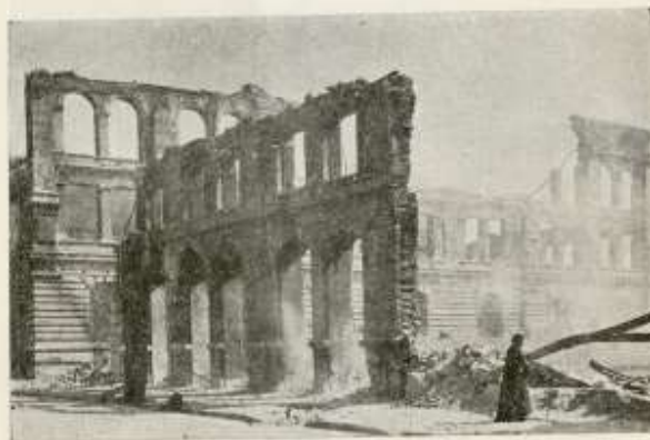
Gran Avenida. Ruinas del edificio de R. Timmerman y Cia. y Ferro Sanguinetti.
