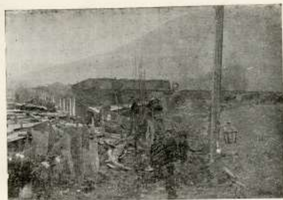
Llay-Llay. Calle Balmaceda
