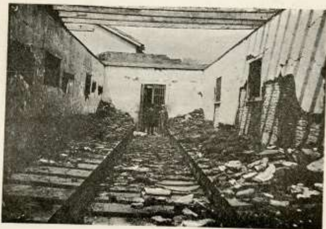
Un calabozo destruido
