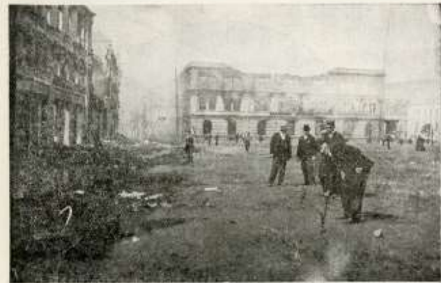
Tomando la hondura de una grieta
